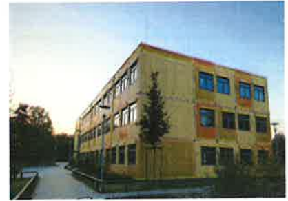
Mittelschule an der Zielstattstraße
